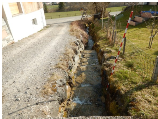
km 0.14, Blick in Fließrichtung
