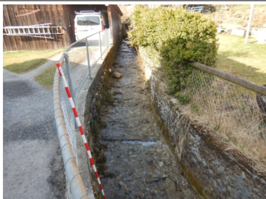
km 0.07, Blick gegen Fliessrichtung
