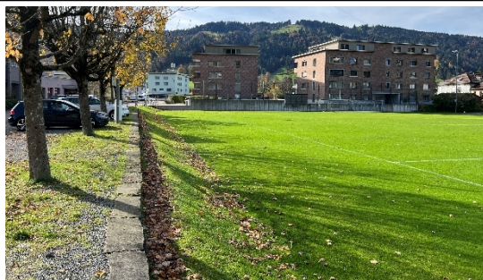
km 0.32, Blick in Fliessrichtung
