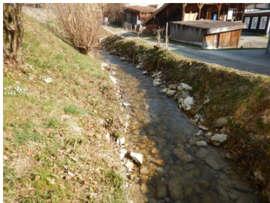
km 0.12, Blick in Fließrichtung
