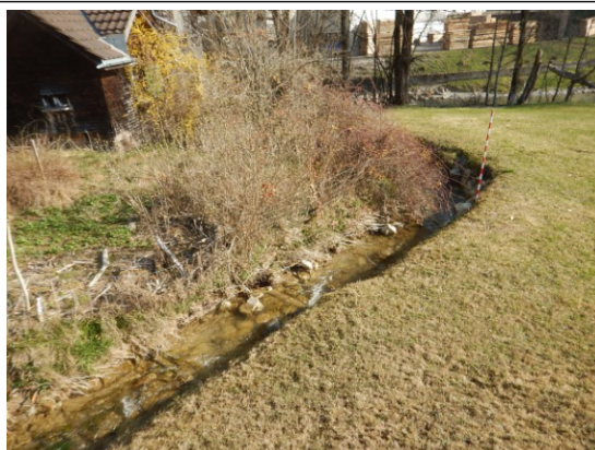
km 0.04, Blick in Fließrichtung
