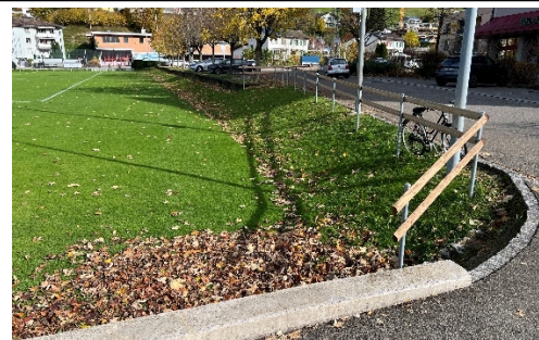
km 0.24, Blick gegen Fliessrichtung
