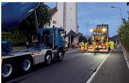
Abschluss Belagsarbeiten bei Nacht
