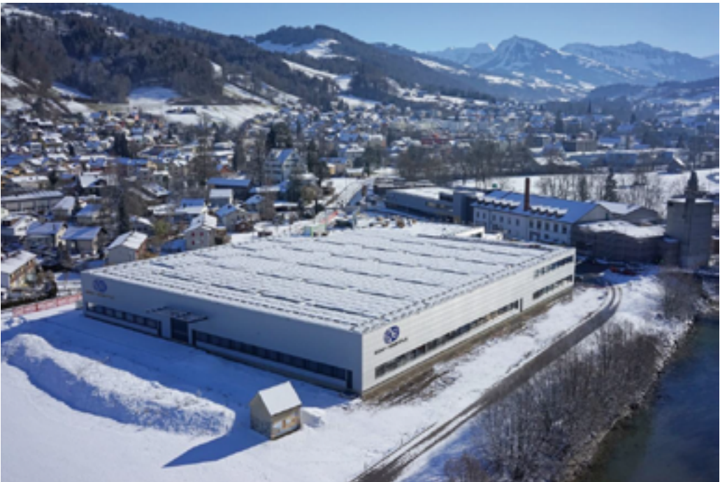
3. Halle von 2015, Richtung Süd-Osten. Die neue Halle wird unten im Bild angebaut (das kleine Häuschen verschwindet)
