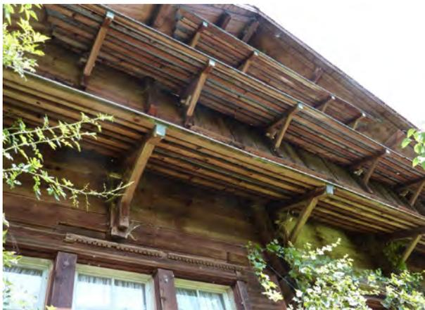
Details Hauptfassade mit Konstruktion Klebdachauflager
