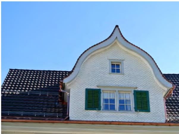
Gaube unter kielbogenförmigem Dach
