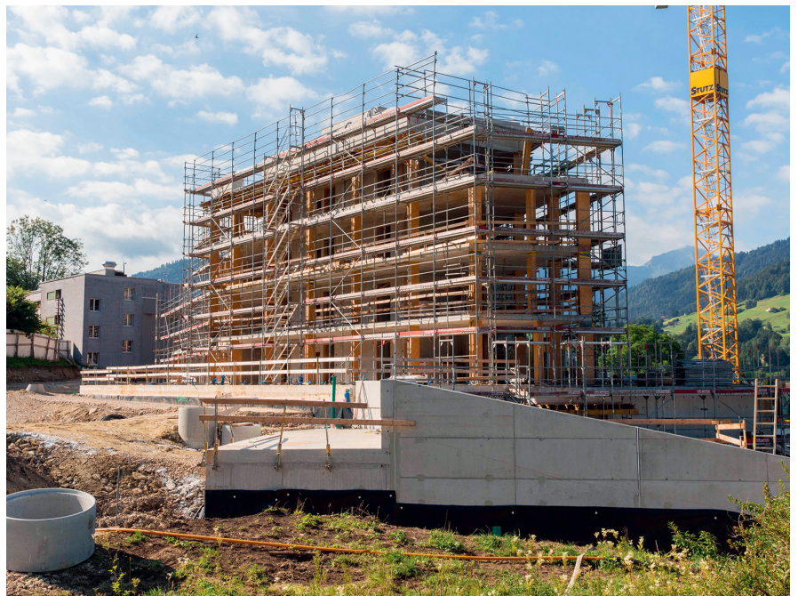
Baustelle Neubau Pflegeheim Wier im August 2022
