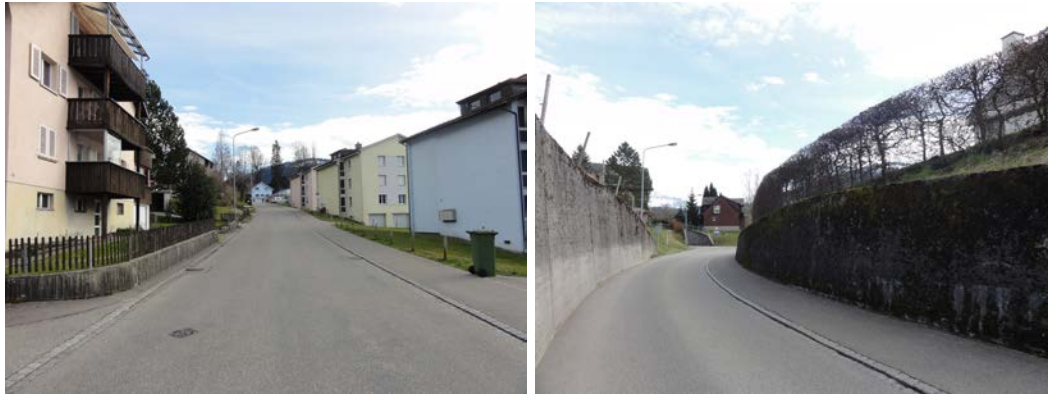
Abb. 12: Räumliches Erscheinungsbild der Rosenbüelstrasse (Abschnitt Ost), Quelle: asa AG
