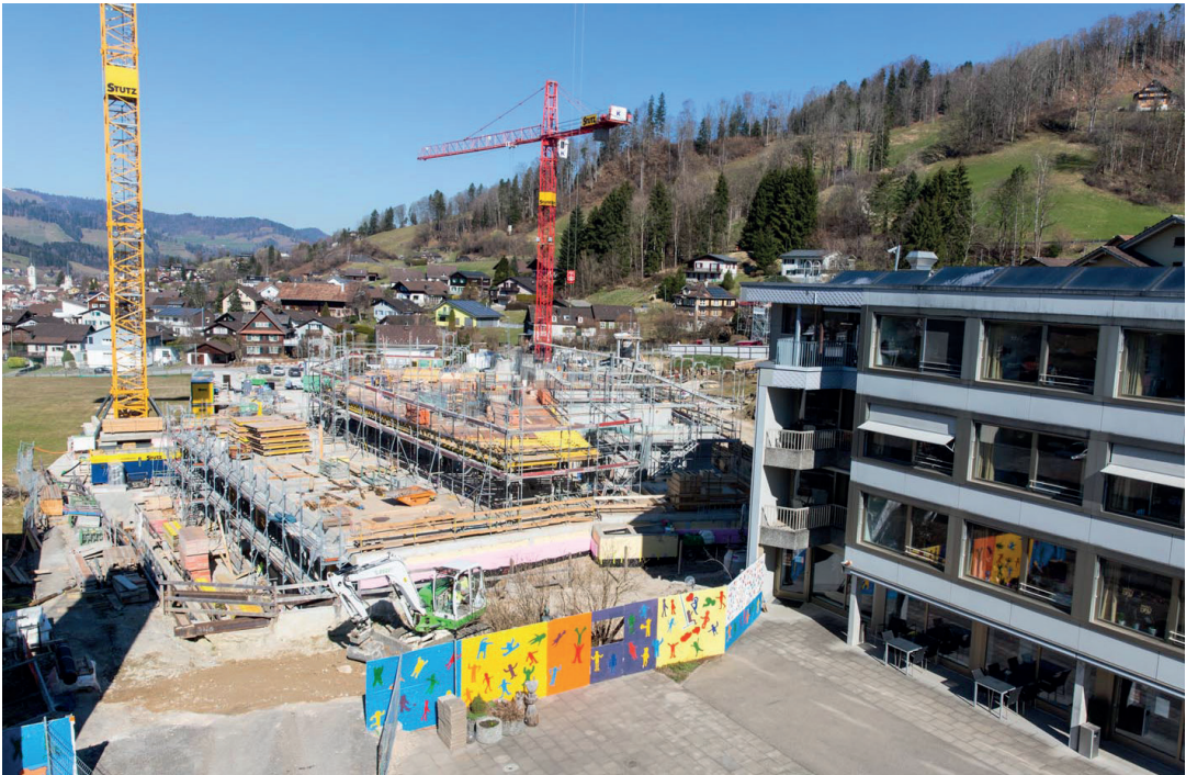
Foto Bauarbeiten Neubau Pflegeheim Wier
