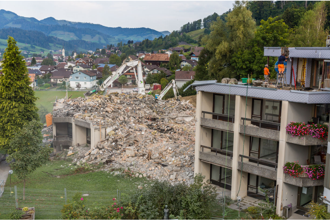
Das Haus C des Alters- und Pflegeheims Wier wird zurückgebaut
