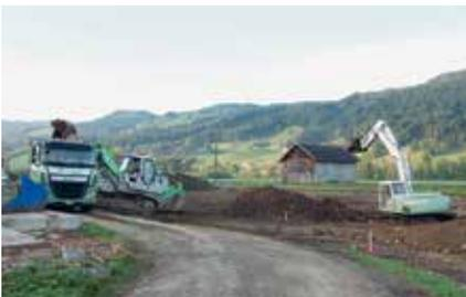
Das angefallene Material wurde gesetzeskonform entsorgt oder wiederverwertet. Glücklicherweise darf der gesamte Kieshaufen mit einer Restbelastung in der Betonherstellung verwendet werden und kann damit kostengünstig in der Region eingesetzt werden. Die Gesamtkosten belaufen sich
